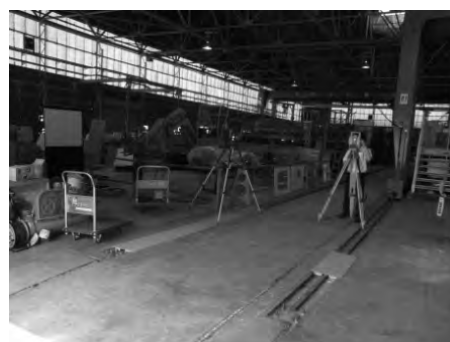
写真-3.7 トータルステーション計測状況
