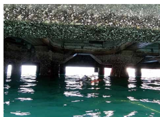
図1 改良した定点保持機能を実装した点検用ROVによる棧橋下面調査の実施
