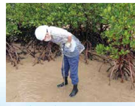
マングローブ周囲の地盤調査状況
