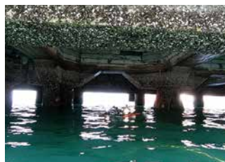
定点保持機能を実装した点検用ROVによる栈橋下面調査の実施
