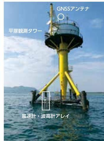
平塚観測タワーに設置した観測機器
