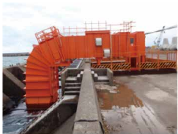
酒田港における多重共振型波力発電システムの実証実験
