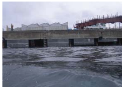
実橋橋での前垂れによる塩分浸透抑制効果の確認実験の状況
