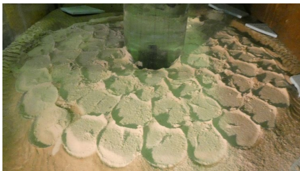
写真-2.4 CASE-4 終了後に袋型根固材を撤去した写真
