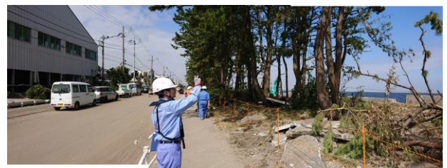
図-1.5 福浦の護岸パラペット（写真右）の倒壊と浸水した背後地（写真左）の状況
