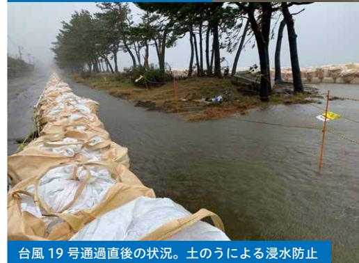
台風19号通過直後の状況。土のうによる浸水防止
